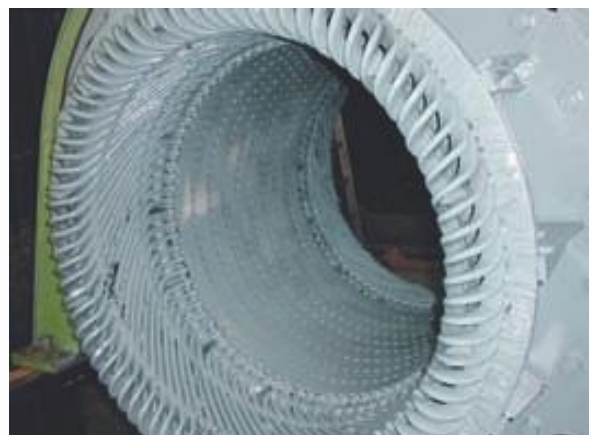
Bild 2: Der neu bewickelte Stator, versehen mit Schutzlack, fertig für die Montage
